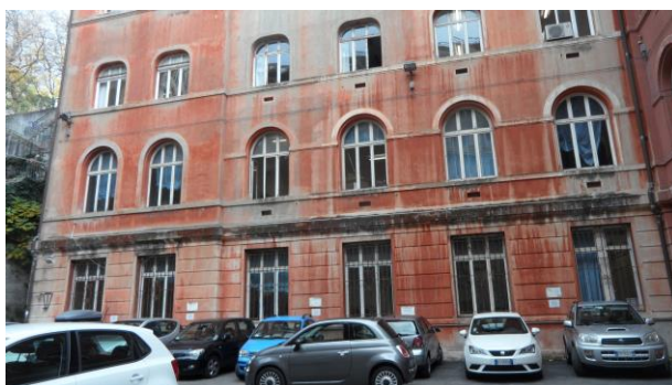
Figura 4.10 – Serramenti in legno e vetro singolo – Facciata Viale Bottero
