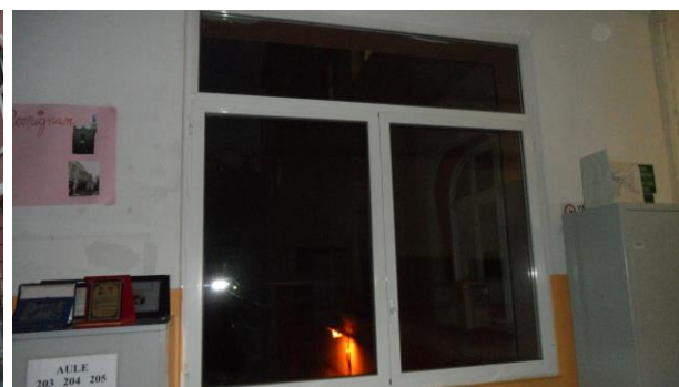
Figura 4.11 - Serramenti in pvc e vetrocamera – Interno piano quarto
