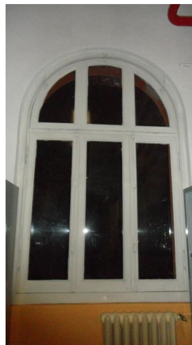
Figura 8.3 – Infissi esistenti con telaio in legno e vetro singolo
