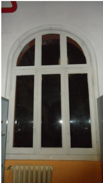
Figura 4.12 – Serramenti in legno e vetro singolo – Interno piano secondo
