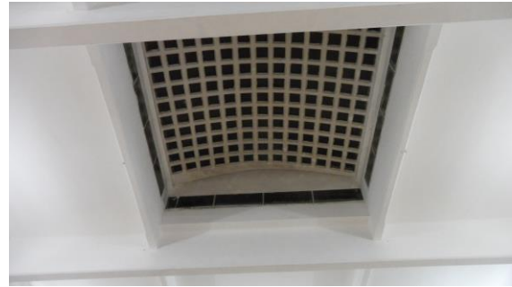
Figura 4.7 – Copertura palestra - particolare
